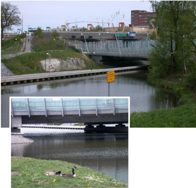
Double passage pour la faune (supérieur et inférieur) au niveau d'un boulevard périphérique ; en bas : couple de bernaches nonnettes nidifiant sur le passage inférieur (Stockholm).
