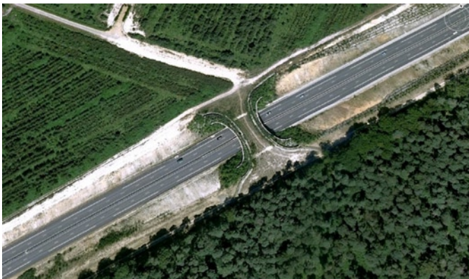
Passage supérieur pour la faune et les promeneurs sur l'A84 dans la traversée de la forêt domaniale de Rennes. Image GoogleEarth.
