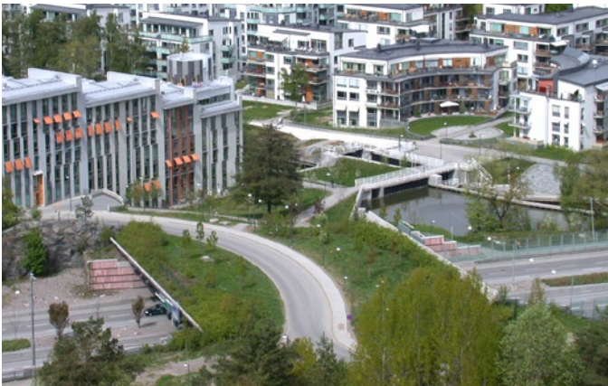
Un exemple de pont végétalisé au-dessus d'un boulevard périphérique, créant un lien entre des espaces verts urbains et une forêt proche (Stockholm).
