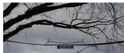
Solution de défragmentation, état de Washington : écureuiloduc (voire pour muscardins, loirs, lérots...) pour traverser en sécurité une grande voie de circulation sans se faire écraser
