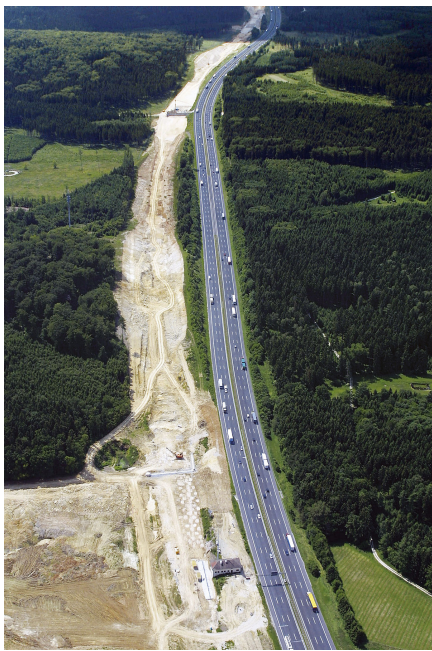
Au XX e siècle, les infrastructures de transports deviennent de puissants facteurs de fragmentation des forêts : construction du TGV Nuremberg-Ingolstadt (2001) coupant la forêt de Kösching)
