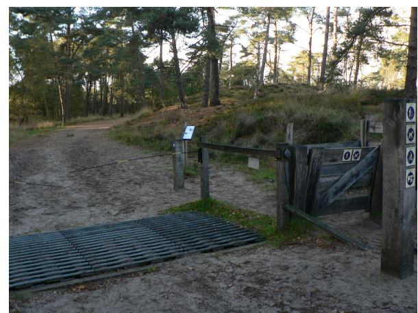
Des systèmes simples de type Pas canadien ; constitué de tubes ronds disposés parallèlement au-dessus du vide, constituant une barrière qui effraye de nombreux animaux, empêchent les entrées ou sorties de certains animaux sauvages dans les réserves naturelles, mais permettant le passage de l'Homme et de véhicules (Réserve naturelle belge de Kalmthout)
