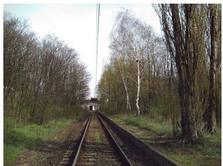
Les voies existantes, avec une gestion appropriée peuvent avoir un rôle de corridor, mais dans les zones d'accélération ou décélération, des trains nettoyeurs doivent débarrasser les rails des feuilles mortes qui font patiner les trains [2] .
