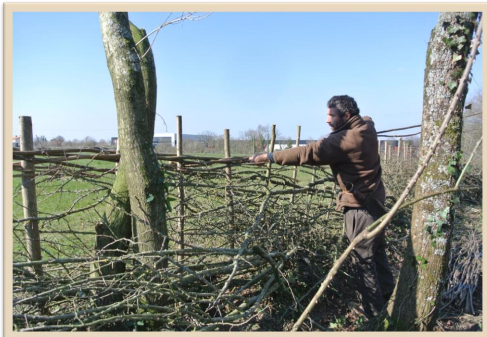
Façonnage de la tresse, beaumur
