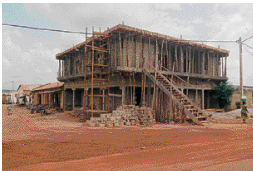
Photo 5. Echafaudage et étayage d'un bâtiment avec des piquets de teck, à Korhogo. Teak pole scaffolding and props for a building in Korhogo.
