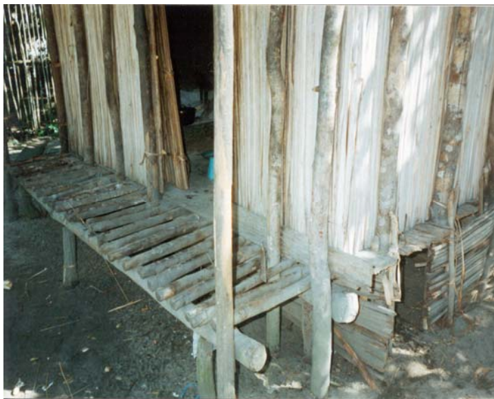
Photo 20 : Des gaulettes de Voapaka mena utilisées pour les karatsaka
