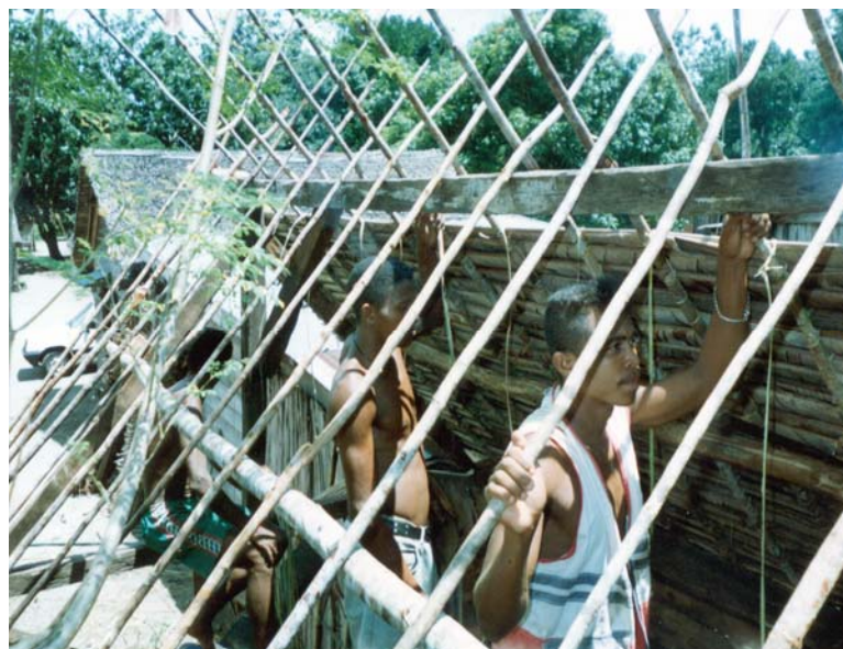
Photo 22 : Des gaulettes à la place du Dypsis arenarium pour le montage du Fitoroka
