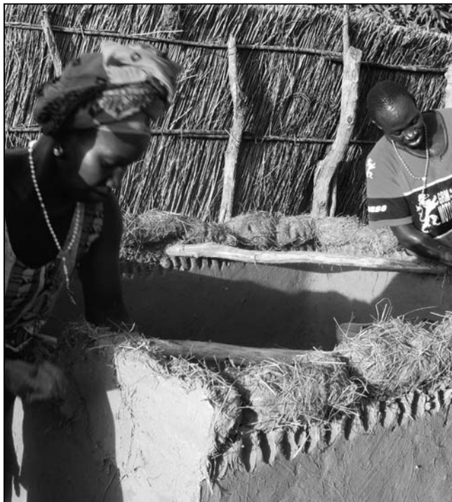
Les formateurs et apprentis construisent le grenier bo
