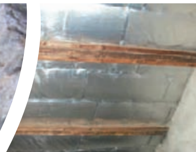
Chevrons masqués par un isolant
