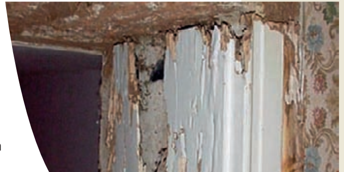
Attaques sur un montant de porte
