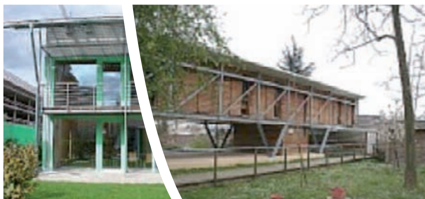
Construction sur poteaux béton
