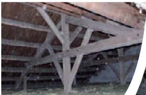
Charpente en combles perdus
