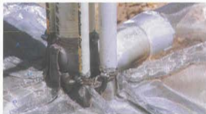
PHOTO 3 : Le grillage métallique antitermite, innovation plus récente, est utilisé pour envelopper le périmètre des fondations et pour empêcher les termites de pénétrer dans le bâtiment par le biais des canalisations. (Photo : Termi-Mesh Florida LLC)
