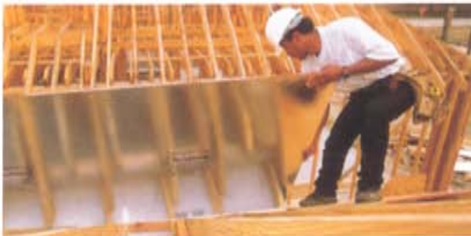
PHOTO 7 : La construction avec des produits du bois traités au borate peut protéger la structure contre les termites dans certaines situations. (Photo : Louisiana-Pacific® SmartGUARD™)
