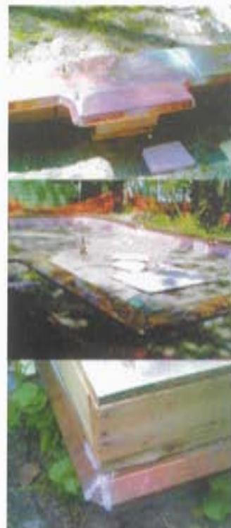
PHOTOS 4, 5 et 6 : Les boucliers antitermite, ou barrières en tôle, sont installés entre la partie supérieure des fondations et la lisse basse. Cette barrière, qui dépasse du bâtiment et est inclinée vers le bas à un angle de 45 degrés, force les termites à construire des cordonnets pour la contourner, ce qui facilite leur détection. (Photos : Tim Myles, University of Toronto)
