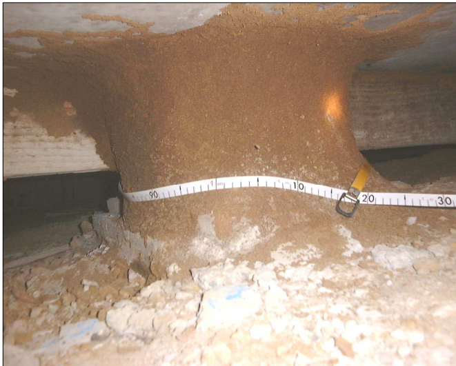
- Une grosse termitière (termite de sol) dans un vide sanitaire, donc au sous sol, avec infestation au 3 ème étage d'un immeuble, diamètre 40 cm. Photo P. Blanès - Cordonnet sur mur. On remarque son traitement en bleu.
