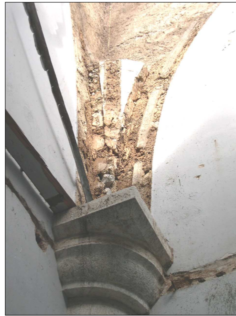
– Vieux Temple de Nouméa : charpente en réfection. On observe les dommages entre la charpente et le plafond. Photos R. Decourt.
