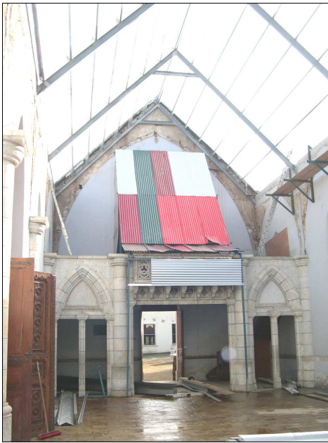
– Vieux Temple de Nouméa : charpente en réfection. On observe les dommages entre la charpente et le plafond. Photos R. Decourt.
