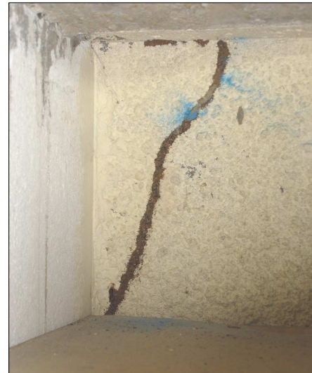
- Une grosse termitière (termite de sol) dans un vide sanitaire, donc au sous sol, avec infestation au 3 ème étage d'un immeuble, diamètre 40 cm. Photo P. Blanès - Cordonnet sur mur. On remarque son traitement en bleu.
