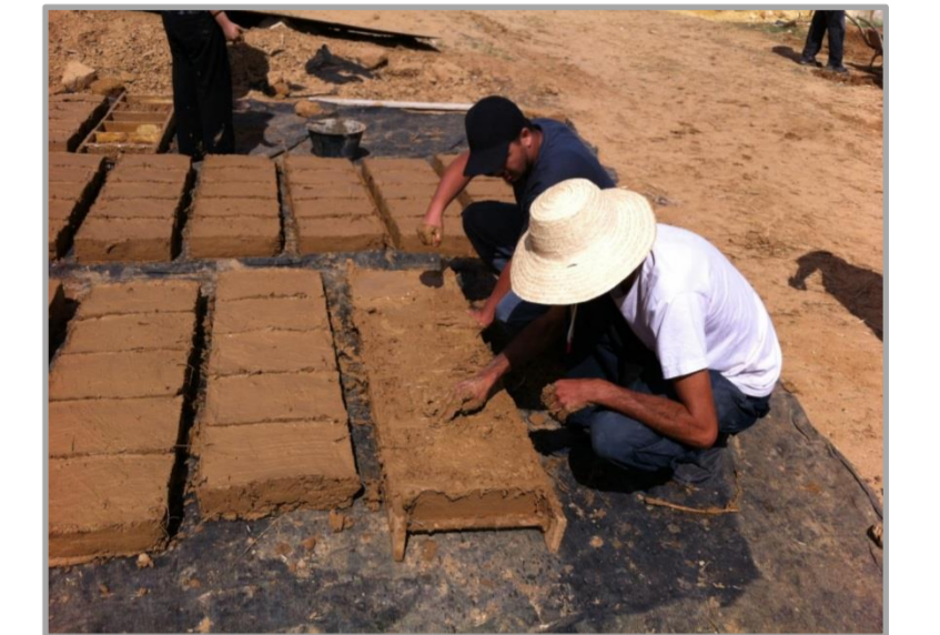
Au GDA Sidi-Amor, chantier participatif de construction écologique en brique de terre crue (adobe) fabriquées sur place
