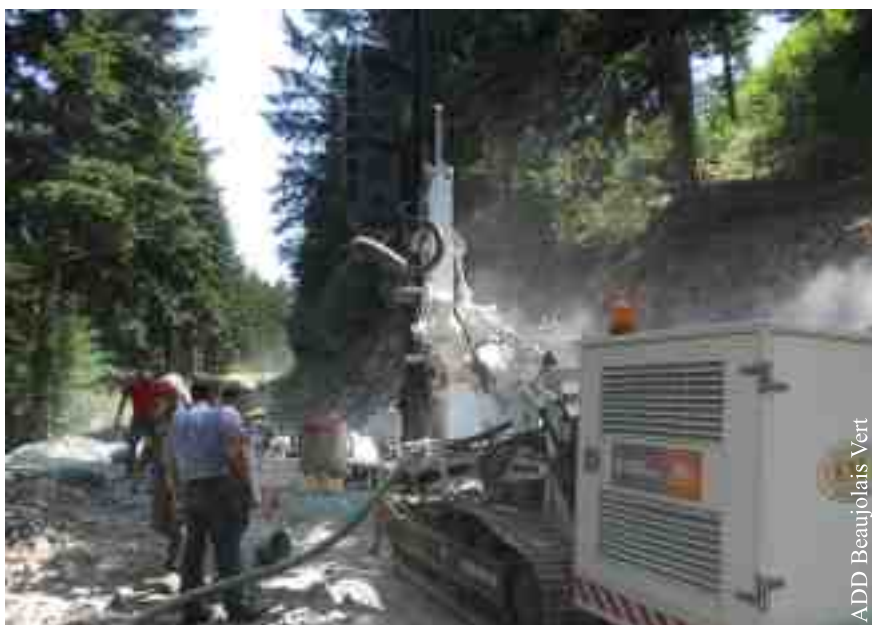
Les premiers forages expérimentaux réalisés en juillet 2013 par la société Vicat.
