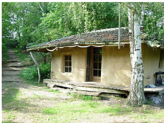
Maison construite avec bottes de pailles couvertes d'argile, à Swalmen (Pays-Bas) ; les murs sont biodégradables et produits avec des ressources locales, à très faible empreinte écologique.
