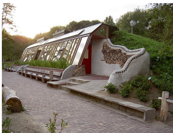
Maison autonome des énergies fossiles (type Earthship), construite avec les matériaux récupérés et recyclés à Zwolle, Pays-Bas
