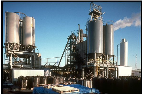
Plus grande usine de réactivation de charbon actif, située à Feluy, Belgique.
