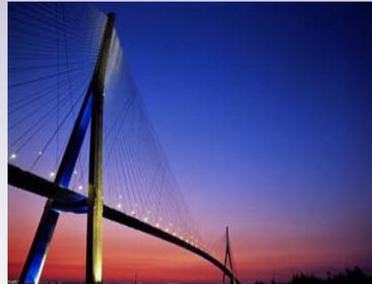
Les ponts suspendus nécessitent des massifs d'ancrages pour « accrocher les câbles » afin de compenser les forces. Les ponts à haubans permettent de ne plus les utiliser et facilitent les changements des câbles grâce à l'absence des deux gros câbles porteurs.
