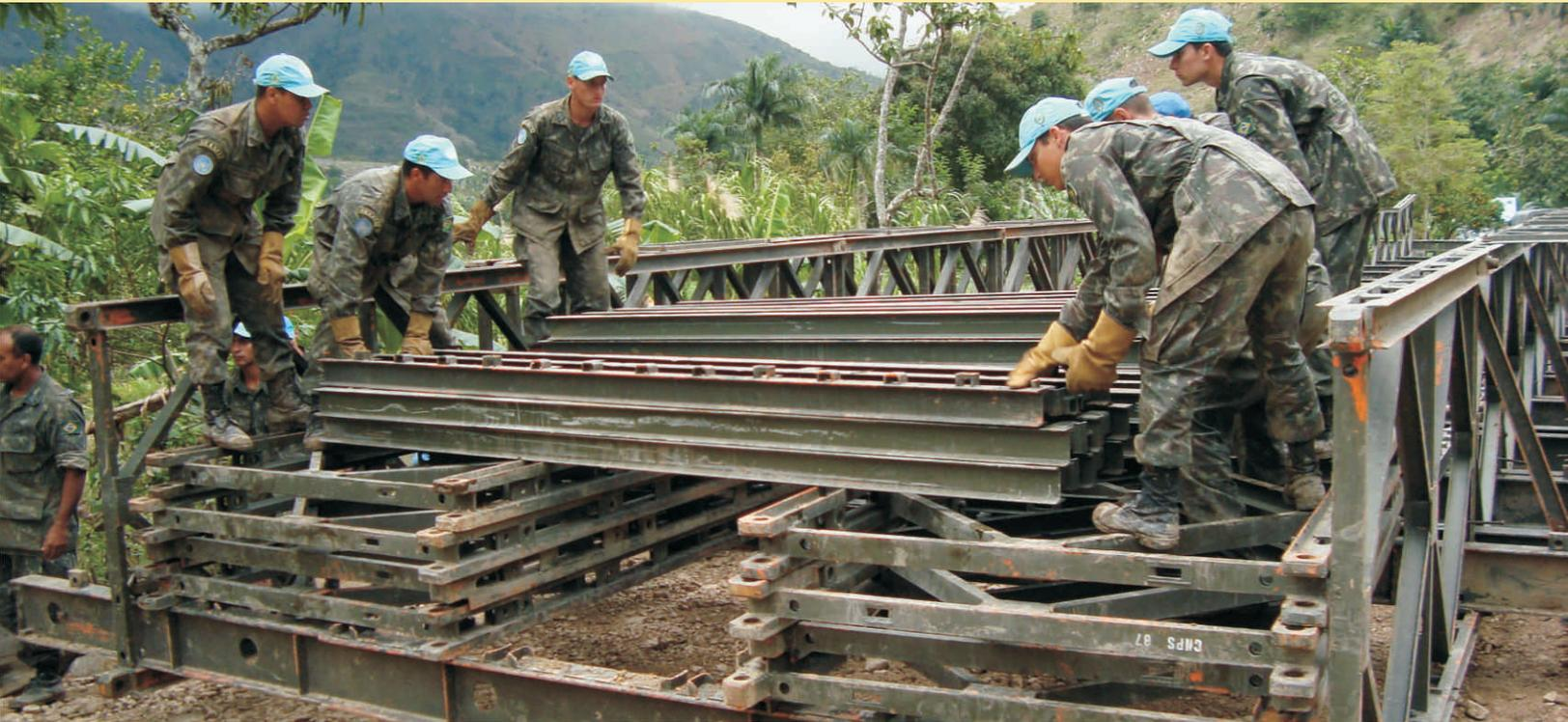
Long de 20,40 mètres et mesurant 6 mètres de large, le pont jeté sur la rivière Bouyaha est capable de supporter approximativement 65 tonnes. Sa durée minimale de vie est de 30 ans.
