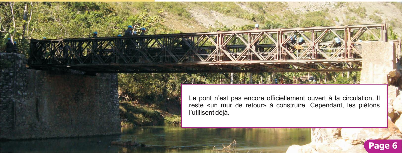
Le pont n'est pas encore officiellement ouvert à la circulation. Il reste «un mur de retour» à construire. Cependant, les piétons l'utilisent déjà.
