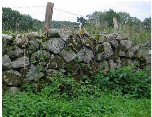
Les pierres sont posées par **lit**. Ce mode de pose nécessite un calibrage de chaque pierre qu'ensuite on appellera **Moellon**. Ce type de mur est très souvent situé à l'intérieur des villages
