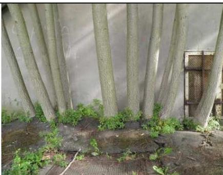
Dégât envers le trottoir et un bâtiment à Nanterre-Triage, causé par l'ailante (Photo B. Lisan).
