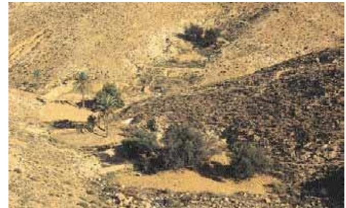
Vue et profil du "**jessour**", système d'exploitation des eaux de ruissellement : le ruissellement de l'eau et des sédiments de la campagne vallonnée sont capturés derrière les barrages («**Tabia**») dans le fond de la vallée.
