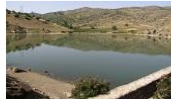
Lac collinaire dans la région nord Marocain installé pour contre le problème d'envasement d'un barrage en aval. Source : Erosion hydrique, <http://www.ma.auf.org/erosion/chapitre1/VI.Lutte.html>
