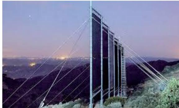
Le projet est composé de 600 m<sup>2</sup> de filets capteurs, deux citernes de 500 m<sup>3</sup>, un puits de forage, 9.000 m de canalisation et 20 branchements domestiques, au sommet du Boutmezguida (Maroc). Source :
