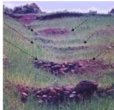
Ravin aménagé dans un champ de céréale : seuils en pierres sèches. Source : Erosion hydrique,
